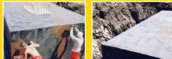
Pro interiéry a při izolacích koupelen se Hydroseal snadno aplikuje i v uzavřených prostor pozv. nevylučuje žádné těkavé látky, nesmrďá a nepoužívá se plamen k natavování. Tím nevzniká nebezpečí poškození plastových rozvodů vody či kanalizace, topení apod.
